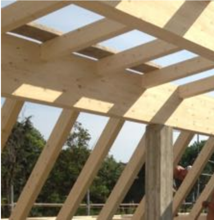
Casa EG Villasanta (MB)
